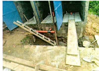
Foto 4: Reposicion de Ambiente (Baños)
