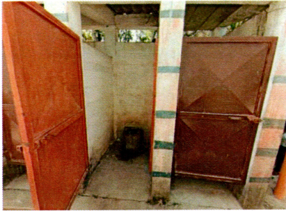
Foto3: Mantenimiento y reparación de puertas de metal.
