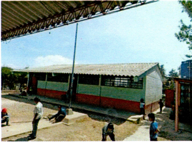
Foto1: Suministro e instalación de lámina troquelada calibre 26
