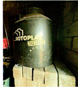
Foto 6: Reparación de Tinaco
