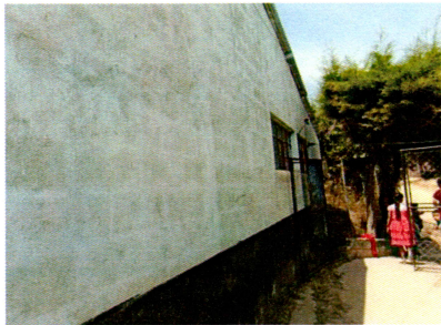
Foto: 5 Pintura para muros interiores y exteriores.
