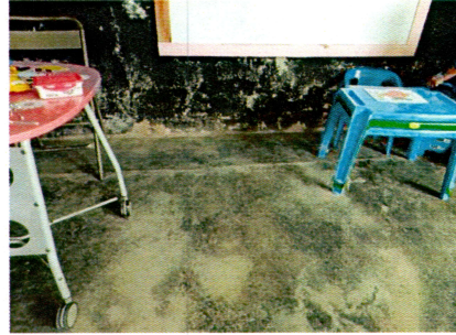
Foto 2: Suministro e instalación de piso de granito de pre-primaria
