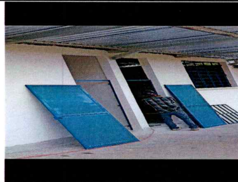
Foto 4: Éste es el proceso de colocacion de puertas.
