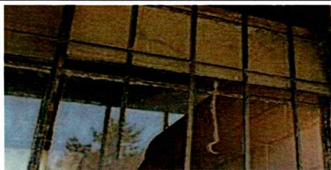
Foto 5: En esta fotografía podemos observar el deterioro de los ventales en su estructura de metal y vidrios rotos.
