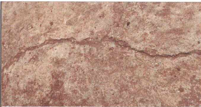
LOSA DE PATIO
