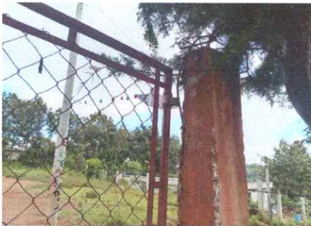
MANTENIMIENTO A PORTONES
