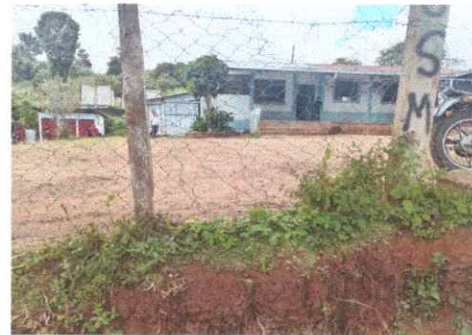
CERCO O MURO PERIMETRAL
