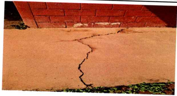
Foto 2: REPARACIÓN DE PISO
