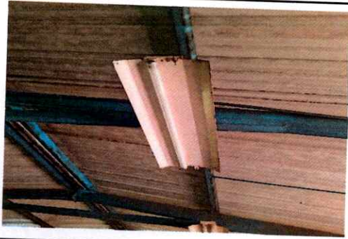
Foto 1: REPARACIÓN DE SISTEMA ELECTRICO
