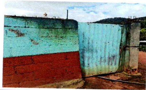
Foto 6: REPARACIÓN DE PORTÓN
