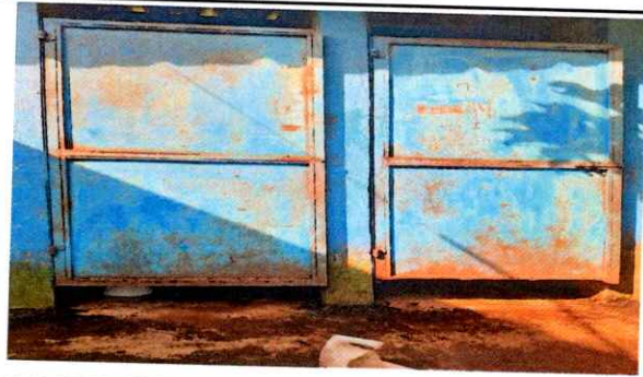
Foto 4: PUERTAS A REPARAR
