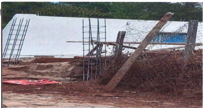
Foto 5: Fundición de columnas de concreto para reforzamiento de portón de ingreso
