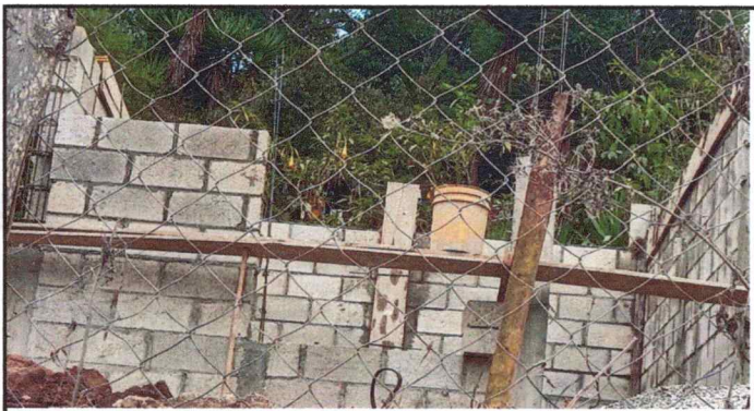
Foto 9: Sustitución de pared
