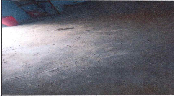
Foto1: Base de concreto para cocina
