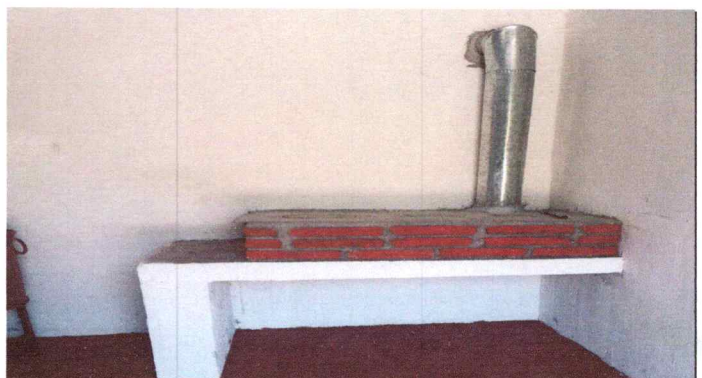
Foto 4: Suministro e instalación de estufa rural con chimenea
