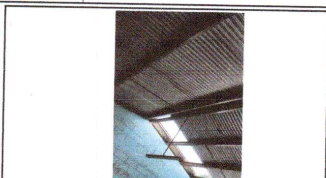
FOTO 2: Suministro e instalación de lamina troquelada Aluzinc calibre 26
