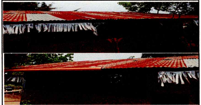
FOTO 2: ESTRUCTURA DE TECHO
