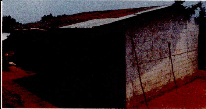
Foto7: REPARACIÓN DE REPELLO Y CERNIDO DE PAREDES
