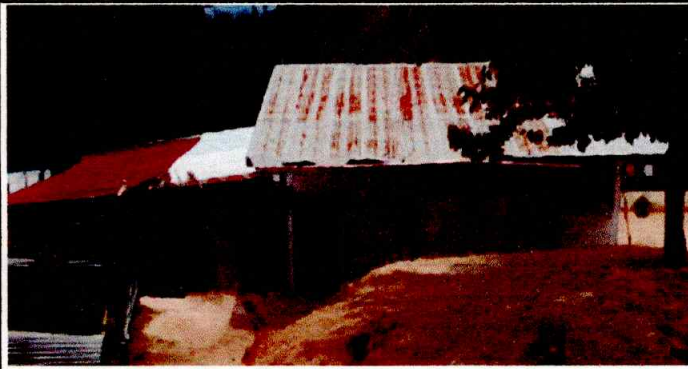
Foto1: CUBIERTA DE TECHO
