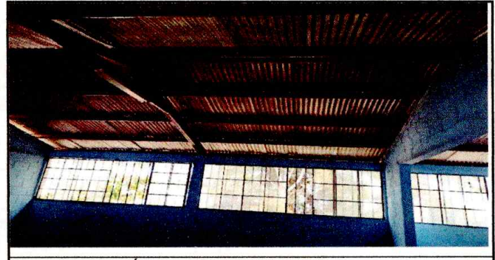
Foto: 6 REPARACIÓN DEL SISTEMA ELECTRICO
