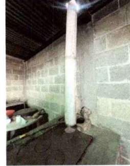
FOTO 2: REPARACIÓN EN AREA DE COCINA
