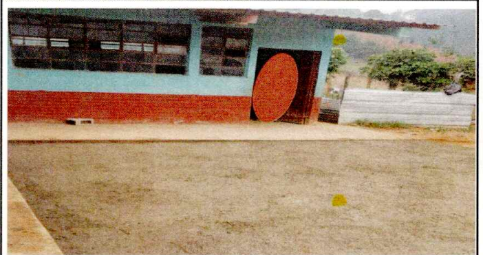
Foto 4: Sustitución de losa de patio.
