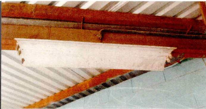
Foto 5: Reparación del sistema Eléctrico.
