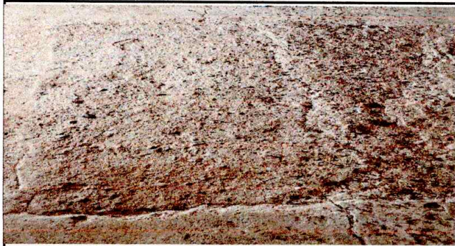
Foto1: REPARAR LOSAS DE PATIO
