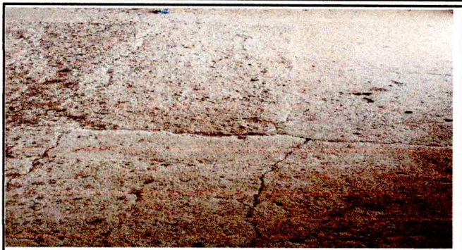
FOTO 2: REPARAR LOSA DE PATIO
