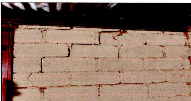
Foto4: REPARACION DE COCINA
