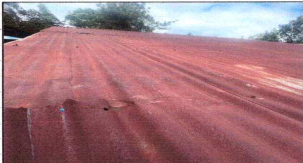
Foto 1: CUBIERTA DE LAMINA: SUSTITUCION DE LAMINA EN AULAS
