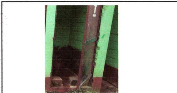
Foto 3: SE SUSTITUIRAN LOS SANITARIOS
