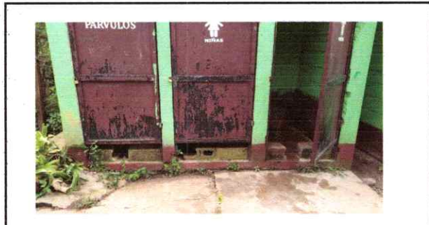
Foto 4: SE REPARARÁ EL AREA DE LOS BAÑOS.
