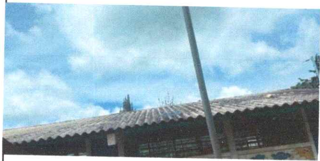
Foto 2: SUSTITUCIÓN LAMINA TROQUELADA CALIBRE 26
