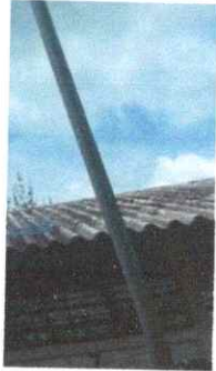
Foto 1: SUSTITUCIÓN LAMINA TROQUELADA CALIBRE 26
