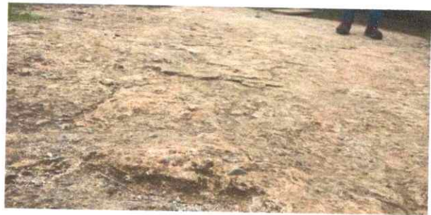
Foto 4: SUSTITUCIÓN LOSA DE PATIO INCLUYE BASE, FUNDICION Y ACABADO
