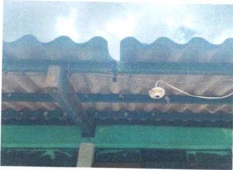
Foto 3: SUSTITUCIÓN LAMINA TROQUELADA CALIBRE 26
