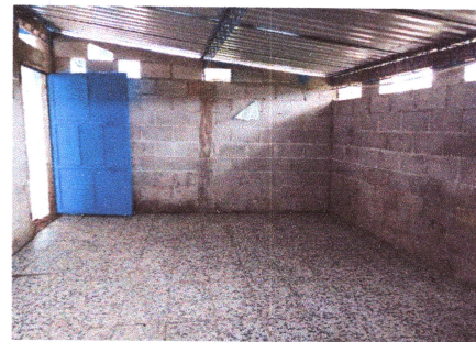
Foto 6: instalacion de piso.
