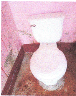
Foto 3: Cambio e instalación de agua en sanitarios
