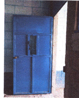
Foto 2: Pintado e instalacion de puertas de las aulas
