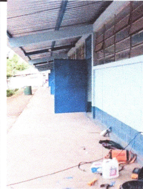
Foto 4: Instalación de puertas en las aulas
