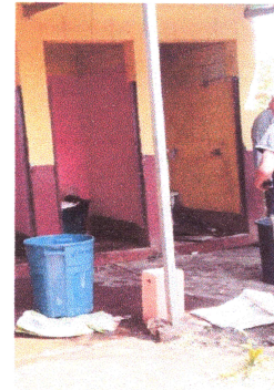
Foto 2: Retiro de puertas de los sanitarios
