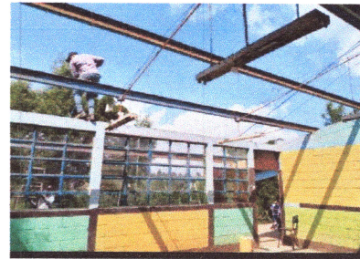
Foto 6: instalacion de techo.
