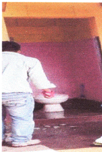
Foto 3: Instación de sanitarios
