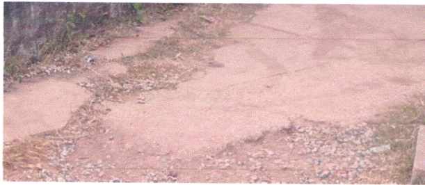
Foto: 5 Reparación de losa en patio
