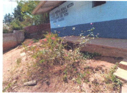
Foto4: Reparación de Losa en Patio
