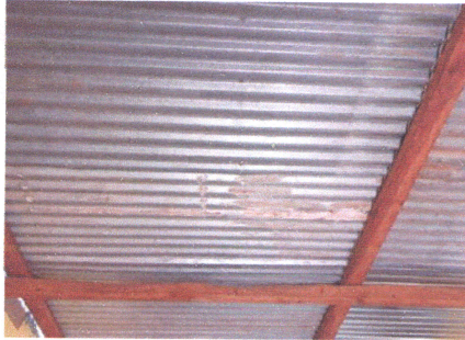
Foto1: Reemplazo de lámina.
