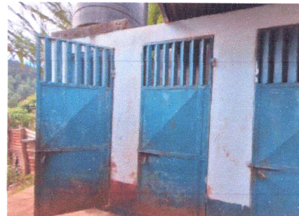
Foto: 6 Reparación de puertas de metal
