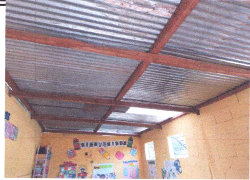
FOTO 2: Reemplazo soporte techo
