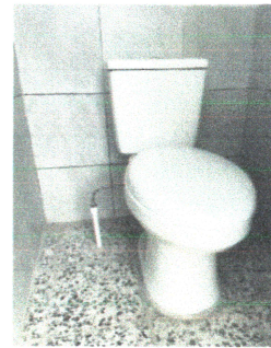
FOTO 2: Sustitución e instalación de inodoros
