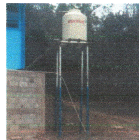
Foto: 5 Reparación de base para tinaco
