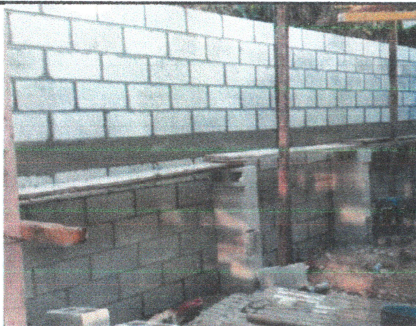
Foto: 5 Reparación de muro perimetral
