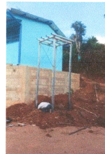
Foto: 5 Reparación de base para tinaco
