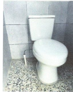
FOTO 2: Sustitución e instalación de inodoros
