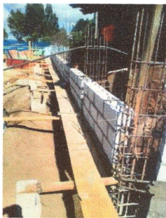
Foto 5 Reparación de muro perimetral
