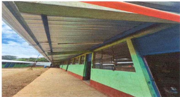
FOTO 1: SUSTITUCION DE LÁMINA TROQUELADA CALIBRE 26
