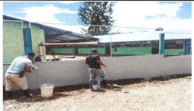
Foto 4: MURO PERIMETRAL SUSTITUCION DE MALLA GALVANIZADA
