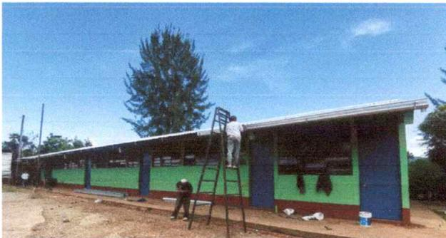
Foto 3: CANALES Y BAJADAS DE AGUA PLUVIAL SUSTITUCION CANAL CUADRADO DE LAMINA CALIBRE 13
