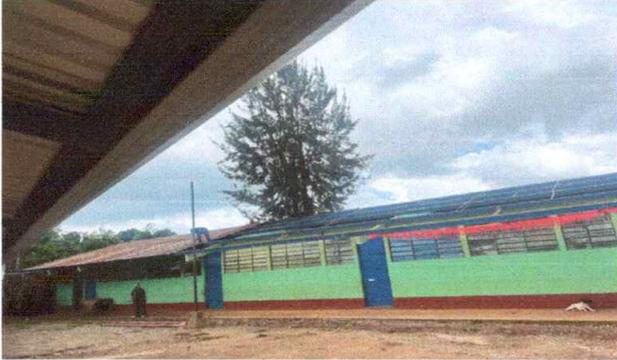
Foto1: CUBIERTA DE LÁMINA SUSTITUCION LAMINA TROQUELADA CALIBRE 26
