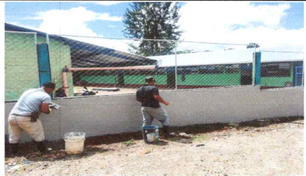
Foto 4: MURO PERIMETRAL SUSTITUCION DE MALLA GALVANIZADA
