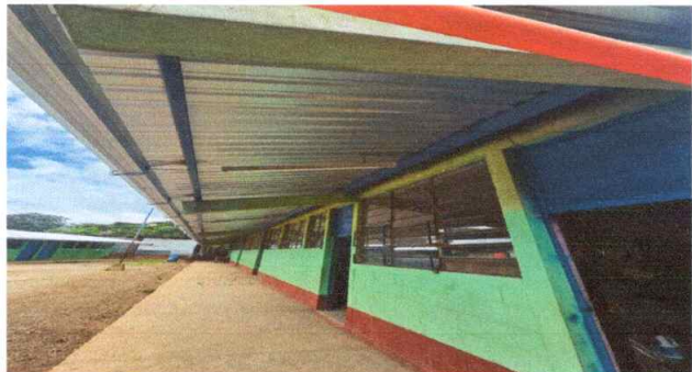
FOTO 1: SUSTITUCION DE LÁMINA TROQUELADA CALIBRE 26
