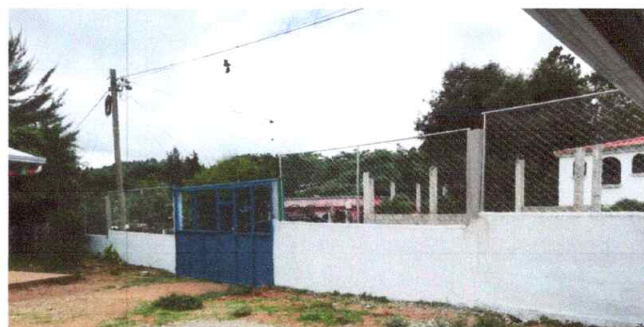
FOTO 4: MURO PERIMETRAL SUSTITUCION DE MALLA GALVANIZADA
