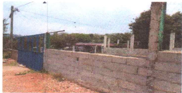
Foto 4: MURO PERIMETRAL (SUSTITUCION DE MALLA GALVANIZADA )
