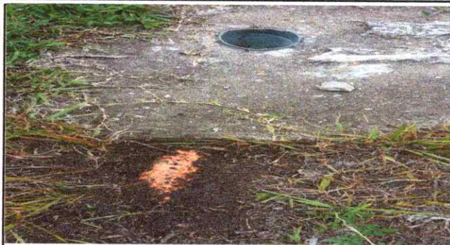
Foto 7: DRENAJES Y RED DE AGUA POTABLE
