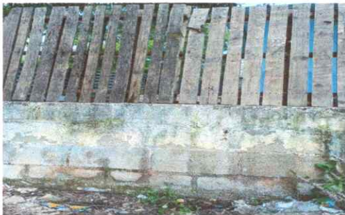
Foto 3: REPARACIÓN DE MURO PERIMETRAL
