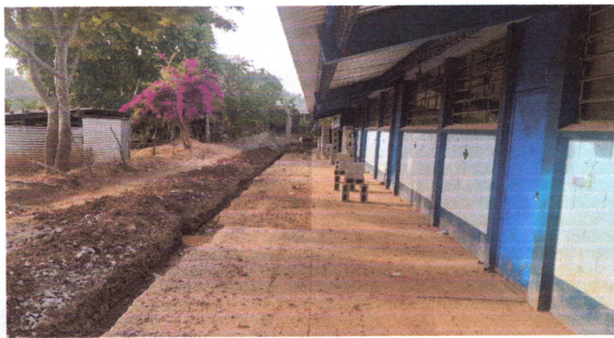
Foto 5: SUSTITUCIÓN DE TORTA DE CONCRETO.
