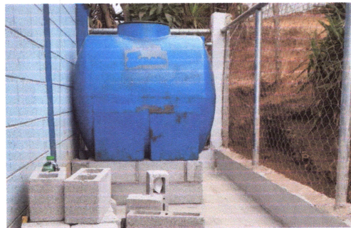
Foto 6: SUSTITUCIÓN DE BASE PARA TINACO, INCLUYE SUMINISTRO E INSTALACIÓN DE ACCESORIOS PARA TINACO REFORZADO.
