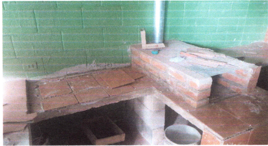
Foto 1: SUMINISTRO E INSTALACIÓN DE DOS COCINAS RURALES COMPLETAS.
