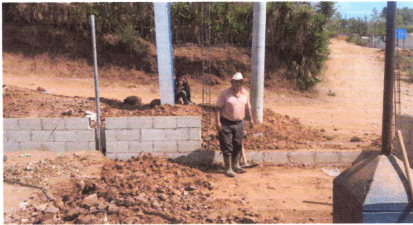
Foto 3: DEMOLICIÓN DE MURO PERIMETRAL EXISTENTE PARA REEMPLAZAR CON CERRAMIENTO DE MURO CON CIMIENTO CORRIDO.
