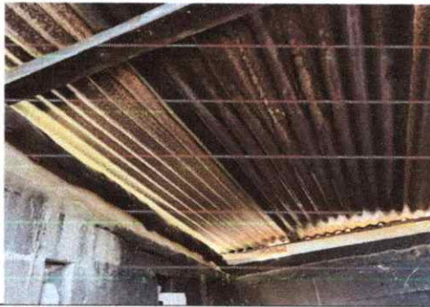
Foto 3: Reparación estructura de Techo.
