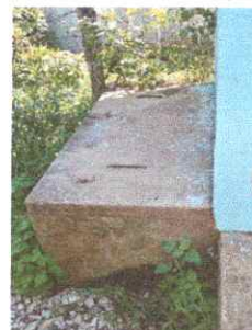
Foto 6: REPARACION Y MANTEMIENTO DE FOSA
