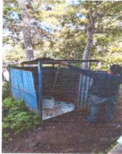
Foto1: SUSTITUCION DE LAMINA TROQUELADA CALIBRE 26
