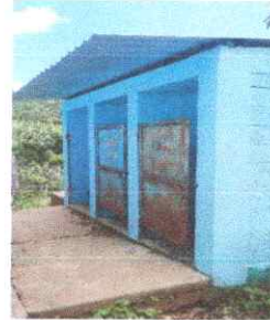
Foto 2: REPARACION Y MANTENIMIENTO DE PUERTAS DE BAÑO
