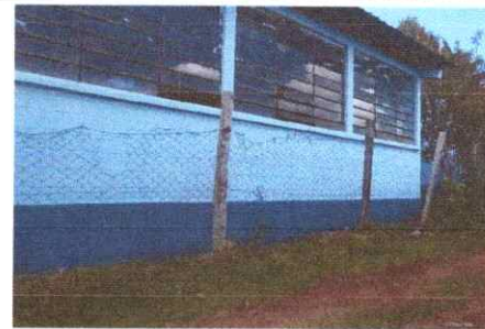
Foto 4: REPARACION DE CERCO PERIMETRAL MALLA
