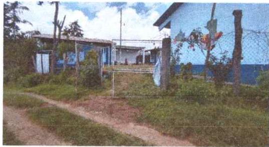
Foto 3: SUSTITUCION DE PORTON DE TUBO CON LAMINA LISA (4*2MTS)
