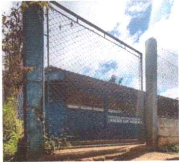
Foto 7. Sustrucción de portón
