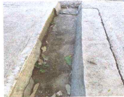
Foto 4: Cuneta de concreto
