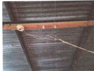
Foto 10. Reparación del sistema eléctrico
