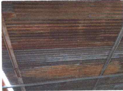
Foto 1: Cubierta de lámina
