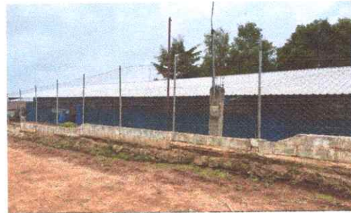
Foto 8: Cerco muro perimetral
