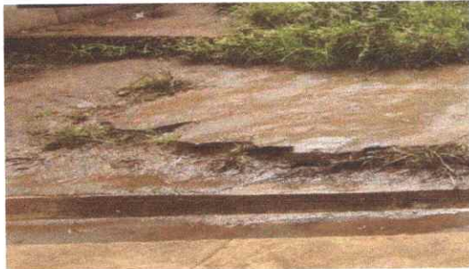
Foto 9: Losa de patio
