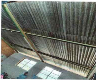
Foto 3: MANTENIMIENTO DE ESTRUCTURA DE TECHO (PINTURA)
