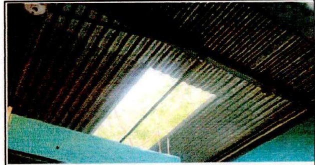
Foto 4: Cubierta de lamina
