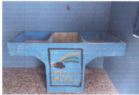
Foto 6: Finalización de reparación de pila.
