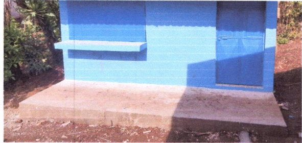
Foto 2: Finalización de reparación de banqueta frente al area de cocina.
