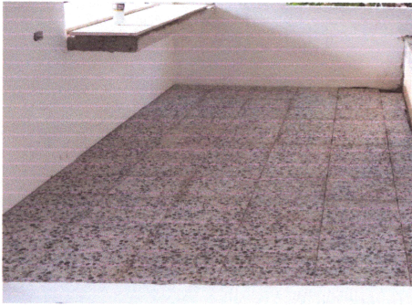
Foto1: Finalización de reparación base para piso de cocina.
