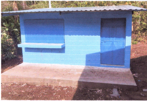
Foto 3: Finalización de reparación de paredes de cocina.
