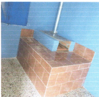
Foto 5: Finalización de reparación de estufa rural completa.
