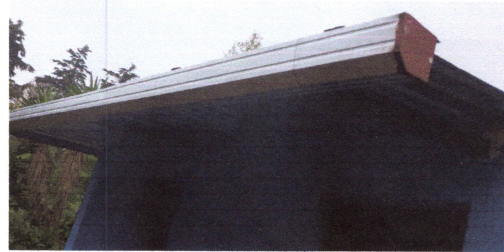
Foto 4: Reparación de canal y bajada de agua pluvial.
