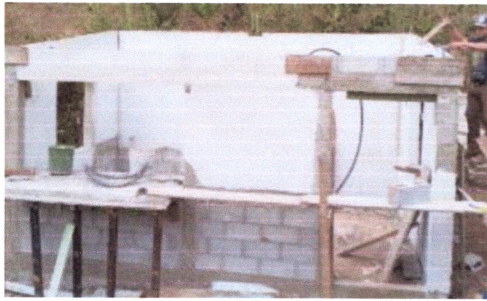
Foto 3: Reparación de paredes de cocina.
