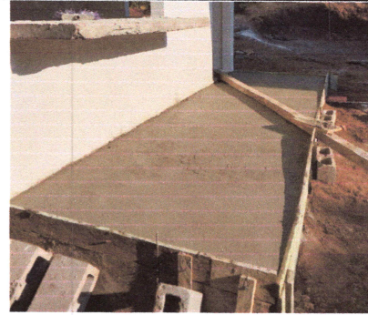
Foto 2: Reparación de banqueta frente al área de cocina.
