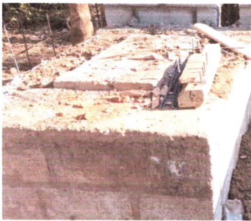
Foto 5: Reparación de estufa rural completa.
