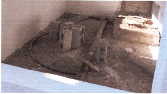
Foto1: Reparación base para piso de cocina.
