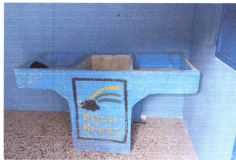
Foto 6: Reparación de pila.
