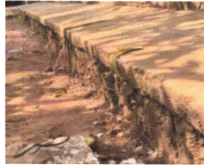
FOTO 2: Reparación de banqueta frente al área de cocina
