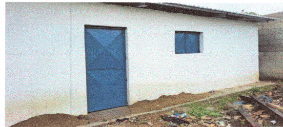
Foto: 6 Sustitución de puerta
