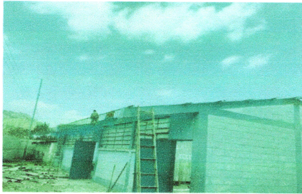
Foto1: Instalación de lámina Aluzinc calibre 26
