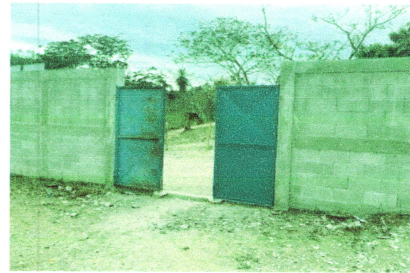
Foto 4: Mantenimiento a porton de metal lijado, cepillado, sujeciones, aplicación de 2 manos de pintura anticorrosiva)
