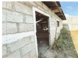
Foto: 6 Sustitución de puerta
