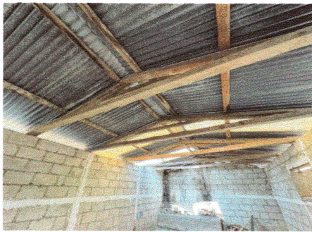
Foto3: Sustitución de base para techo
