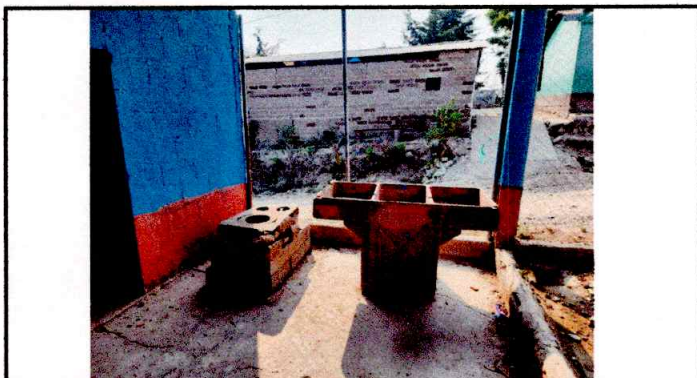
Foto 3: Área de lavado no es funcional
