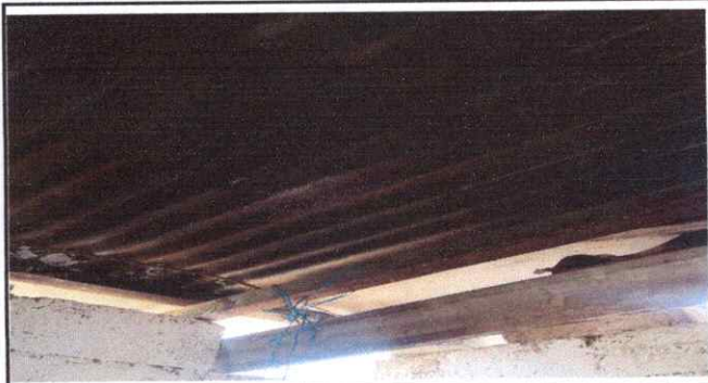
FOTO 1: SUSTITUCIÓN DE LAMINA ACANALADA CALIBRE 28
