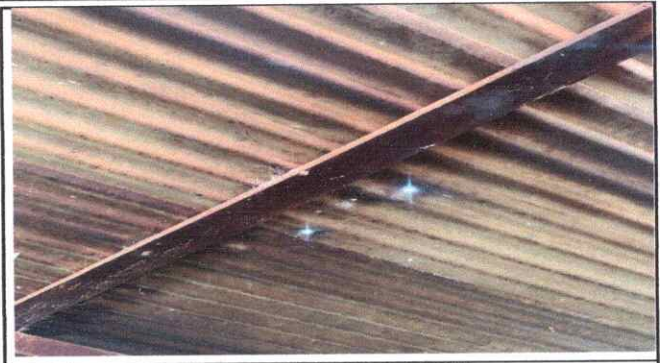
FOTO 2: SUSTITUCIÓN DE ESTRUCTURA DE TECHO
