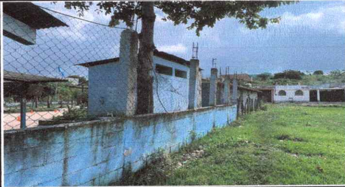
FOTO 7: SUSTITUCIÓN DE CERCO PERIMETRAL CON BLOCK Y MALLA
