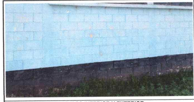
FOTO 6: PINTURA EN MUROS INTERIOR Y EXTERIOR
