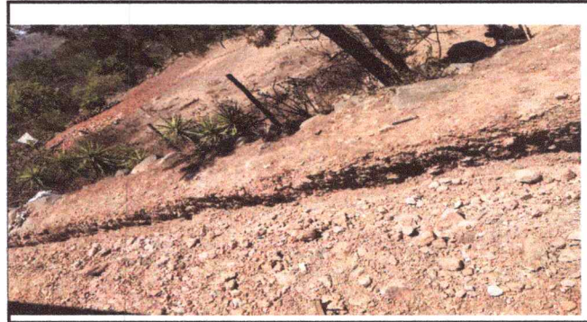
FOTO 2: SEGUIMIENTO REMOZAMIENTO DE DRENAJES Y TUVERIA DE AGUA
