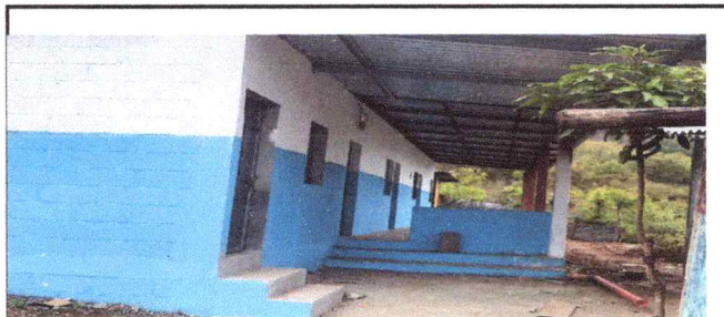
Foto: 5 REMOZAMIENTO DE SERVIO ELECTRICO Y PINTURA
