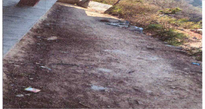
FOTO 2: REMOZAMIENTO DE DRENAJES Y TUBERIA DE AGUA
