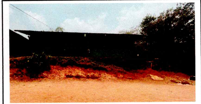
Foto1: SE APRECIA EL ESTADO ACTUAL
