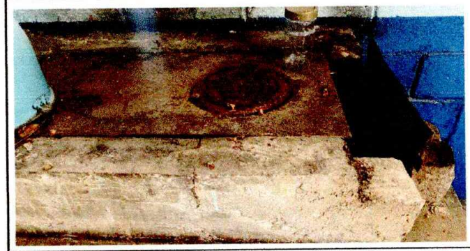
Foto 4: polletones y hornias en mal estado.
