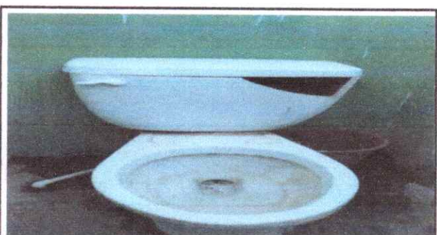
Foto 3: SERVICIO SANITARIO Y SUS ACCESORIOS
