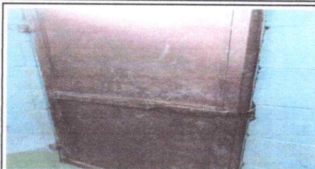
Foto 2: SUSTITUCIÓN DE PUERTAS DE METAL
