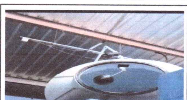
Foto 4: REPARACION Y MANTENIMIENTO DE DEPOSITO DE AGUA
