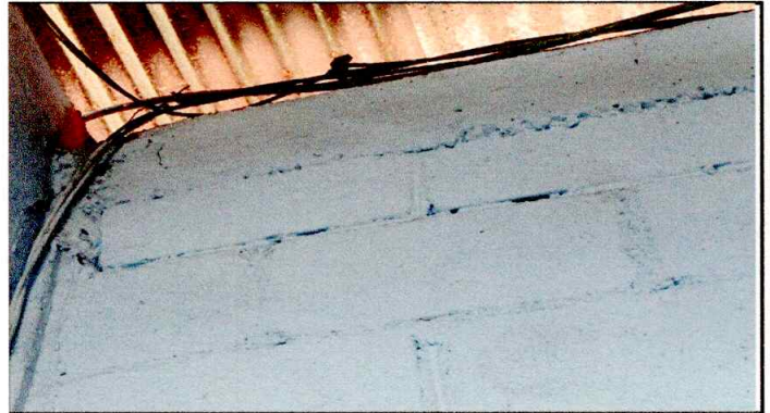
FOTO 8: REPARACIÓN DEL SISTEMA ELÉCTRICO
