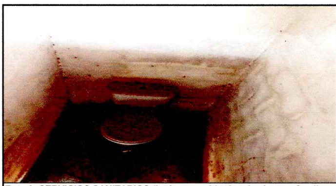
Foto 6: SERVICIOS SANITARIOS (incluye cambio de tubería y profundizar pozo)
