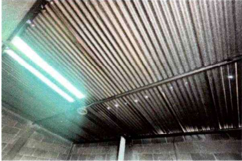
Foto1: Suministro e instalación de lámina troquelada Aluzinc calibre 26 ( incluye tornillos, capote)
