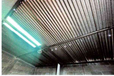
FOTO 2: Sustitución de estructura para techo
