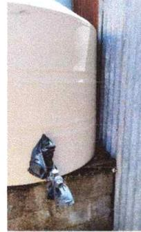
Foto 2: depositos de agua sin funcionar, mal colocados y con grietas
