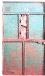
Foto 3: Reparación y mantenimiento en puerta de aulas
