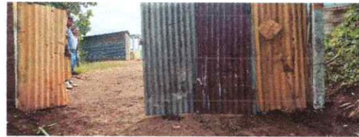
Foto 4: Sustitución de portón con tubo y malla
