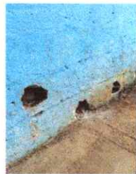
Foto 5: Sustitución de muro perimetral
