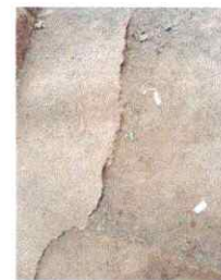
Foto 6: Sustitución Losa de Patio
