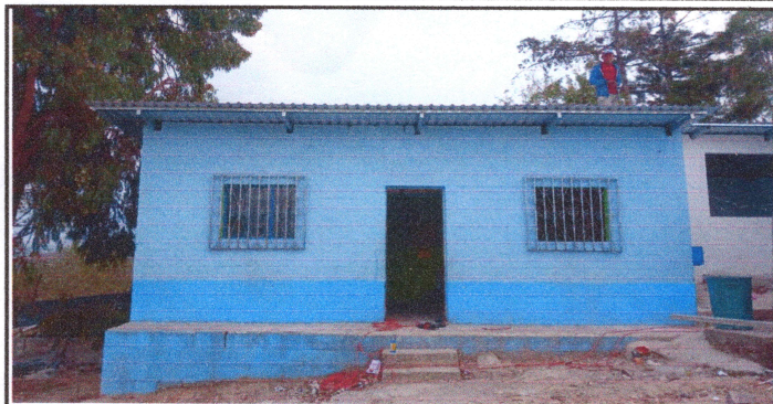
Foto1: Cubierta de lámina
