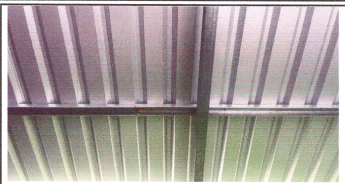
Foto 2: Estructura de techo
