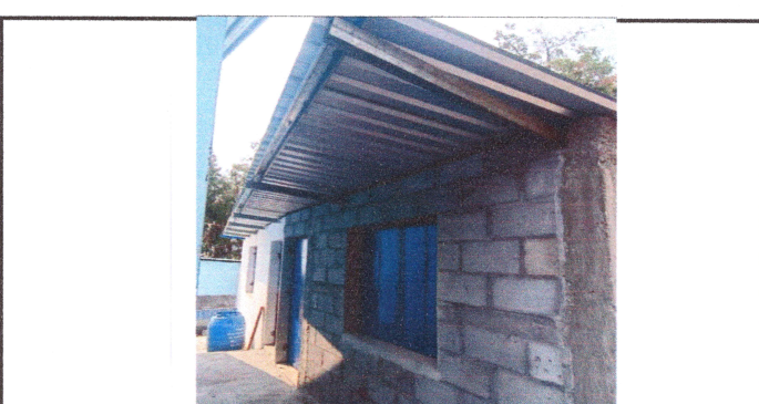
Foto 6: Reparación área de cocina
