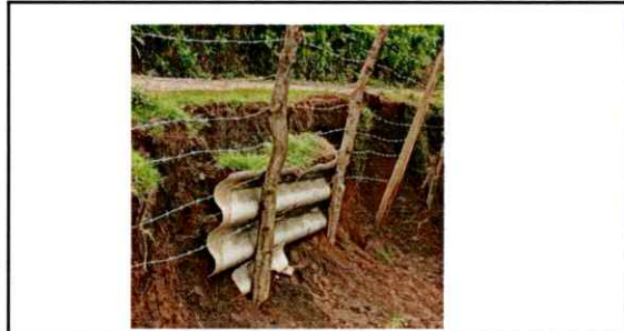
Foto 8: SUSTITUCIÓN MURO DE CONTENCION DEBIDO A PÉSIMO ESTADO
