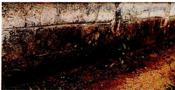
Sustitución en paredes de block en aulas
