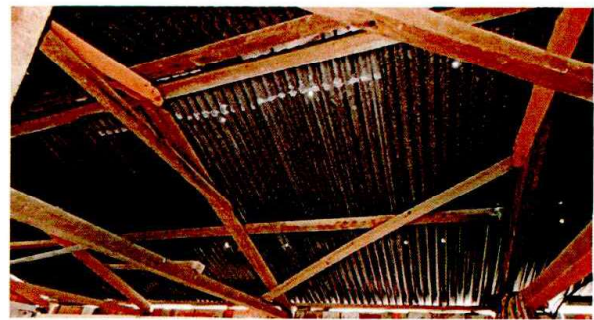
Estructura de techo (estructura de metal galvanizado)
