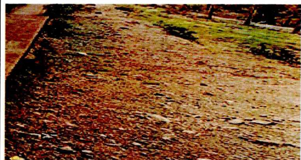
Losa de patio (se incluye suelo previo y fundicion de concreto de 8mm)
