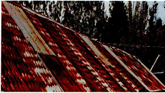
Cubierta de lamina (sustituida por lamina Cal. 26)
